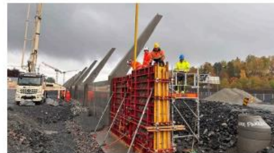
SiGS-betong er brukt i en del av støyskjermen på Ramstadsletta. Foto: Gina Ytteborg / Statens vegvesen
